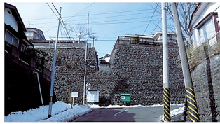
太白区緑ヶ丘1丁目の巨大なひな壇造成地
