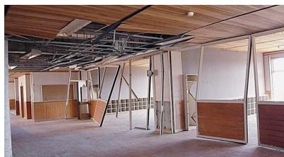
写真08 中浜小学校2階中央スペースの被災状況 (2013.9.28. 撮影)
