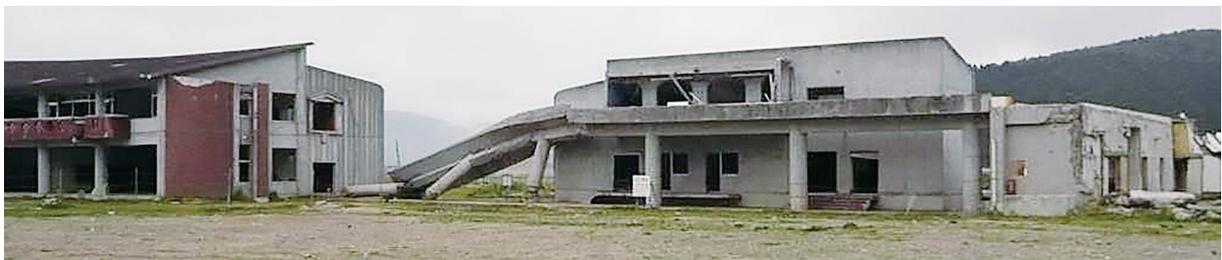
写真 24 津波で押し倒された渡り廊下 (2013.6.1. 撮影)
