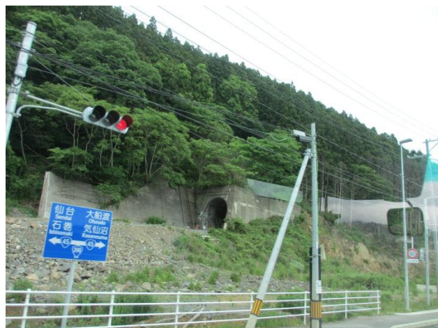
今は使われていないトンネル
