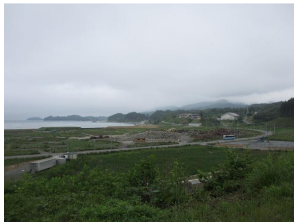
宇津野高台から見た戸倉小学校跡地
